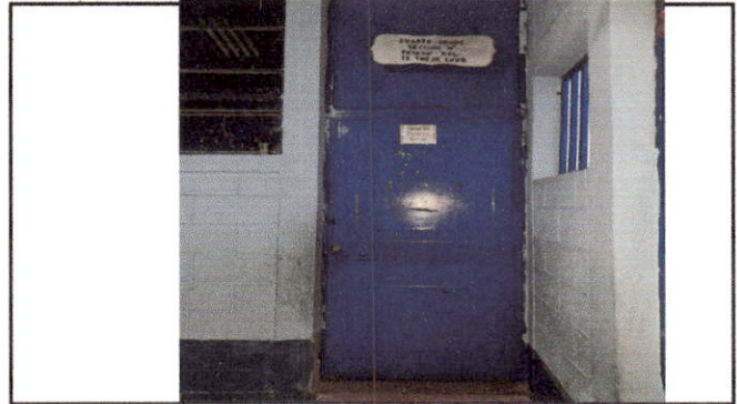
Foto 8: Sustitución de puerta (1 m X 3.8 m)
