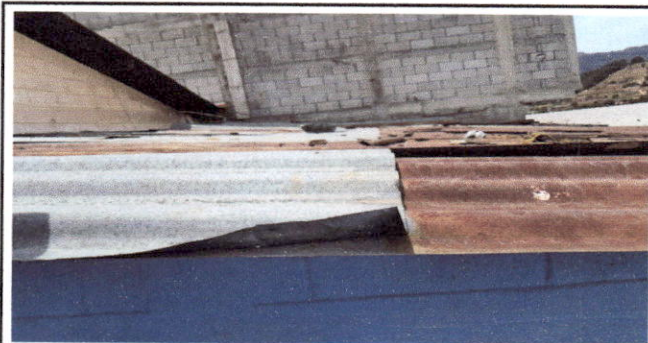
Foto 5: Sustritióñ de làmina, por làmina troquelada aluzinc calibre 26
