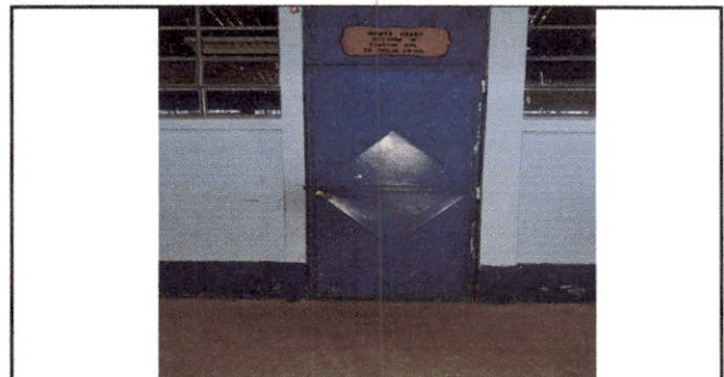
Foto 12: Sustitución de Chapa
