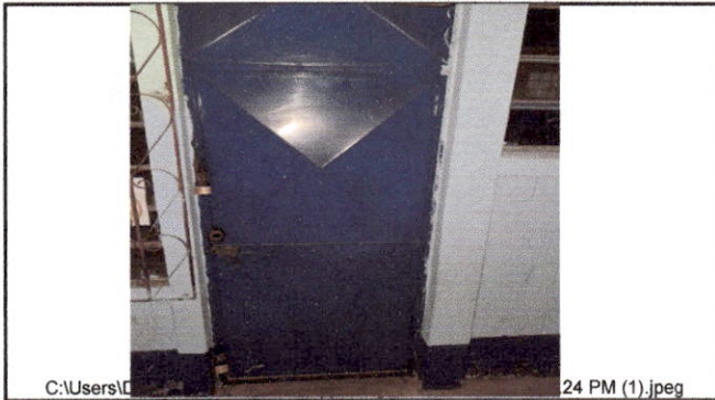
Foto 7: Foto 9: Sustitución de puerta (1 m X 2.92 m)
