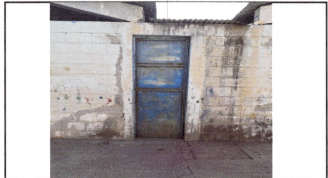
Foto 10: Sustitución de puerta (89 cm X 2.8 m)
