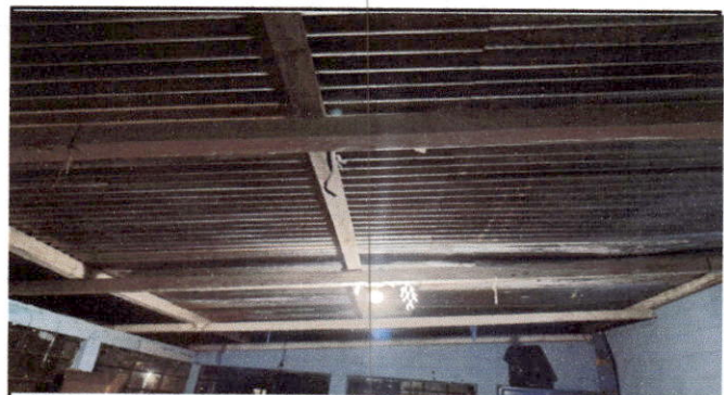
Foto 4: Sustritióñ de Estructura de soporte de madera, por metal
