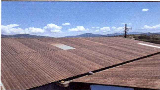
Foto 3: Sustritióñ de làmina, por làmina troquelada aluzinc calibre 26
