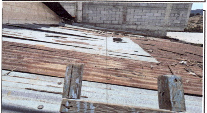
Foto 6: Sustritióñ de làmina, por làmina troquelada aluzinc calibre 26
