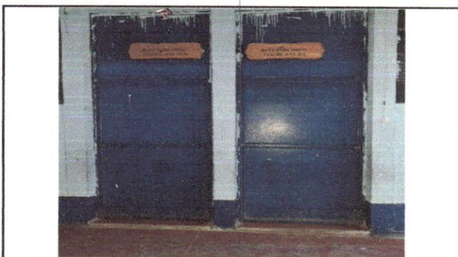
Foto 16: Sustitución de chapa
