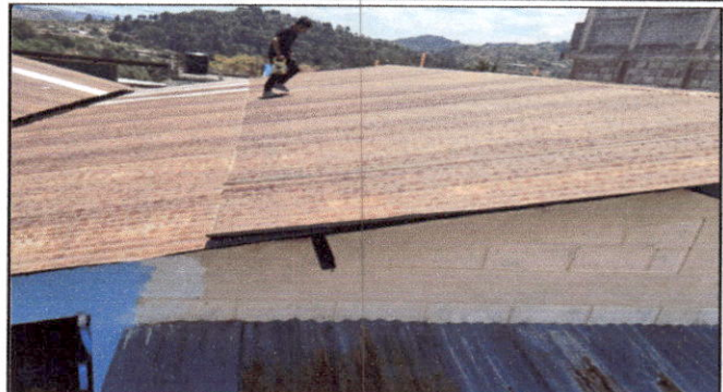
Foto 2: Sustritióñ de làmina, por làmina troquelada aluzinc calibre 26
