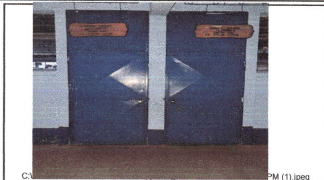
Foto13: Sustitución de chapa
