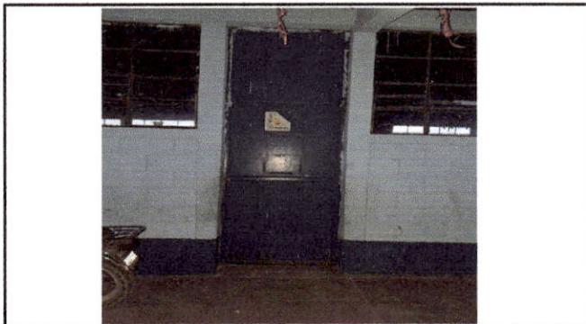
Foto 9: Sustitución de puerta (1 m X 3.8 m)
