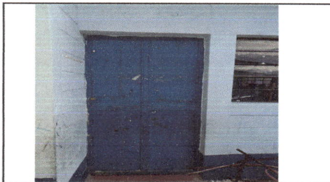
Foto 15: Sustitución de chapa
